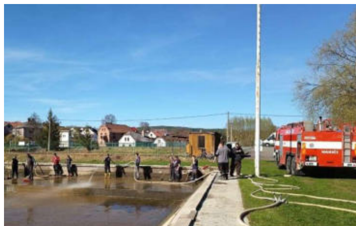
Čištění požární nádrže
