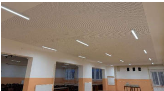
Strop z akustického sádkokartonu a nová svítidla na sále v Mladoticích
