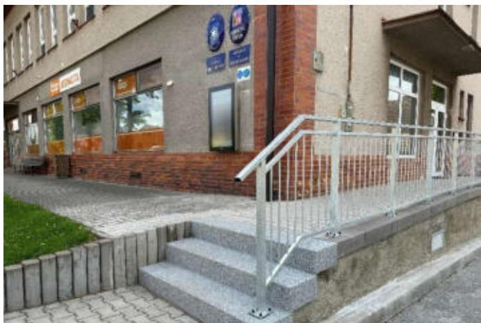
Vstup do OÚ Mladotice po rekonstrukci
