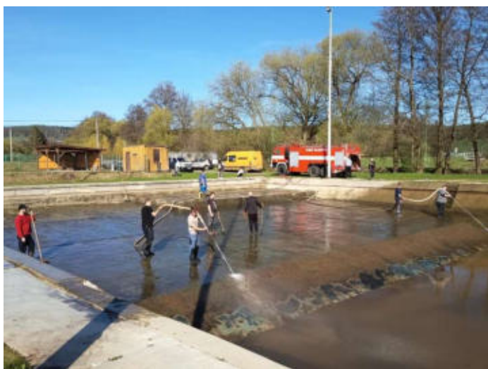
Celé dno požární nádrže bylo proudnicemi vyčištěno za použití hasičské stříkačky
