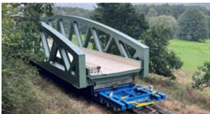
Most při přesunu před stanicí Mladotice – zastávka
