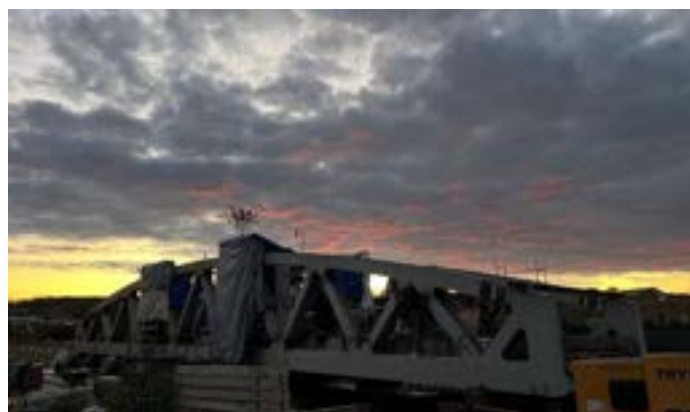
Most o hmotnosti 170 t a délce 44 m při výstavbě v Mladoticích na nádraží
