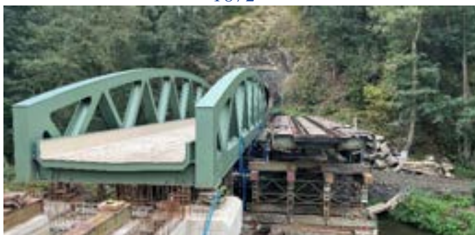
Nový most přes řeku Střelu po přesunu již na svém místě u tunelu, vpravo torzo starého mostu
