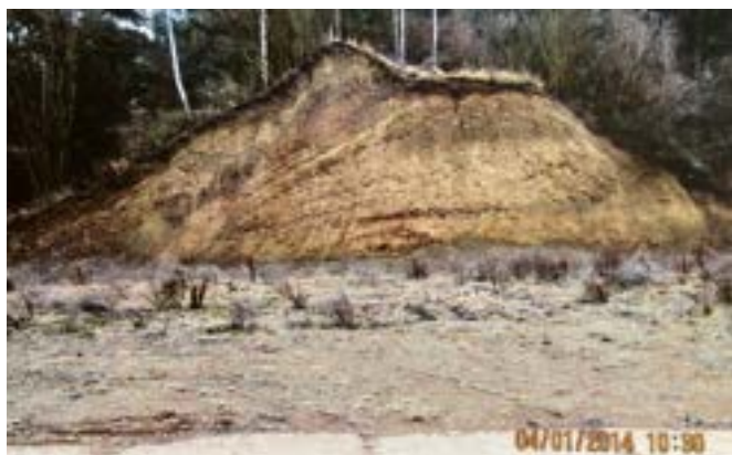
Řez hrází bývalého Mladotického rybníka během výstavby plynovodu Nord Stream I v roce 2014
