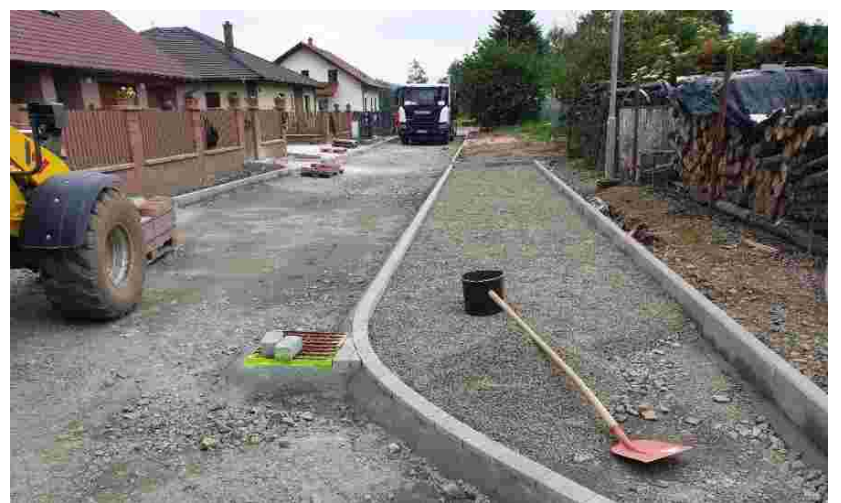
Osazené obrubníky, podklad pod finální povrch
