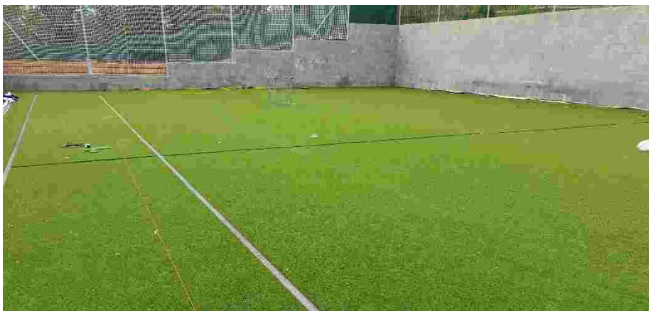
Nově položený povrch hřiště
