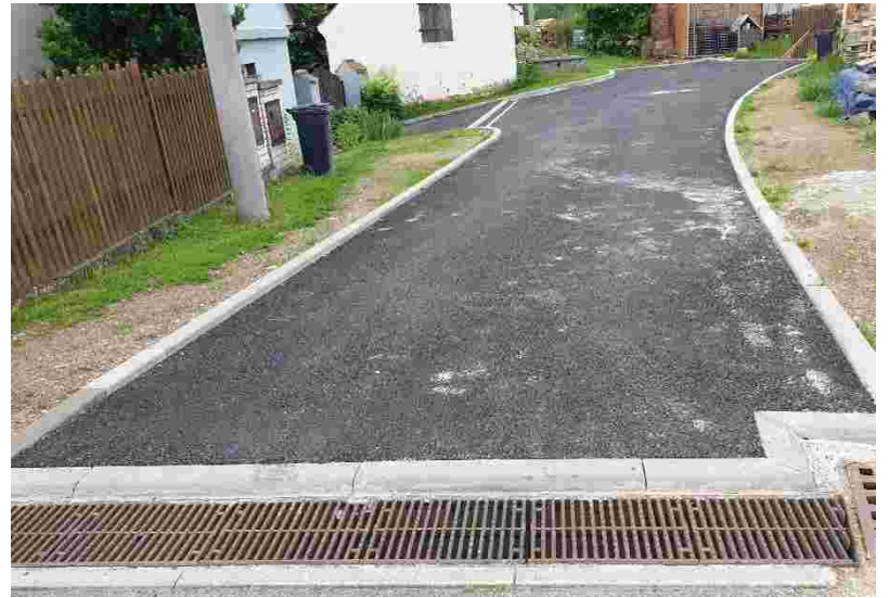
Asfaltový povrch na místní komunikaci
